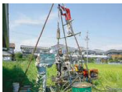
ボーリング調査
